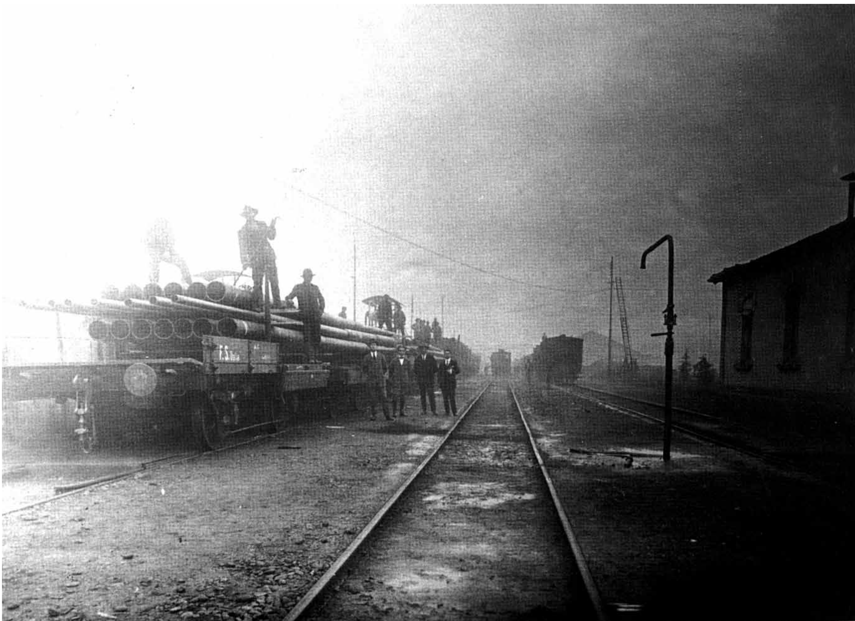
La rete ferroviaria interna, collegata alla stazione di VERDELLO, agevola notevolmente il trasporto dei materiali
