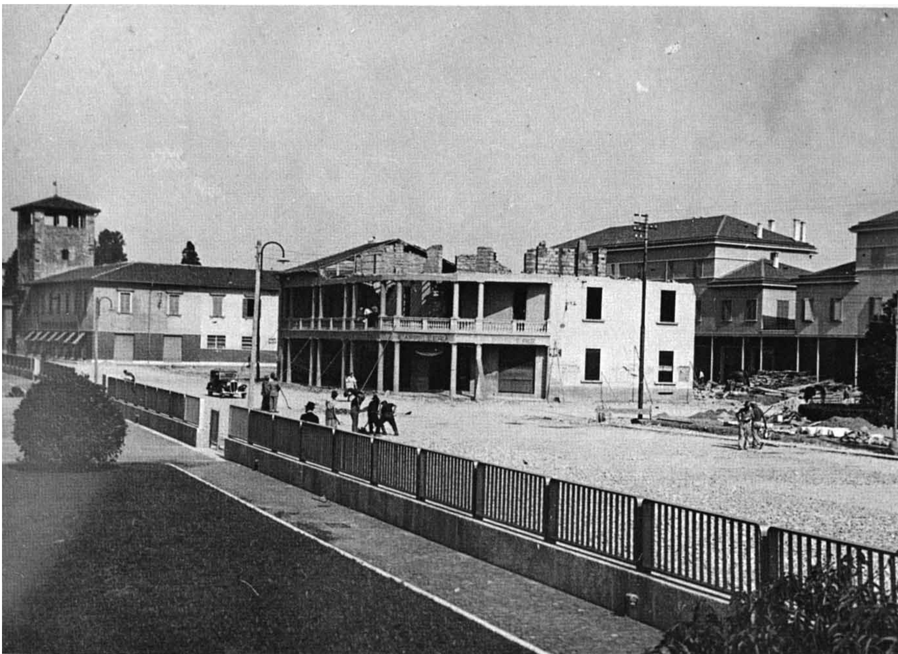
Inizia la costruzione della PIAZZA XX MARZO 1919: opere di demolizione
