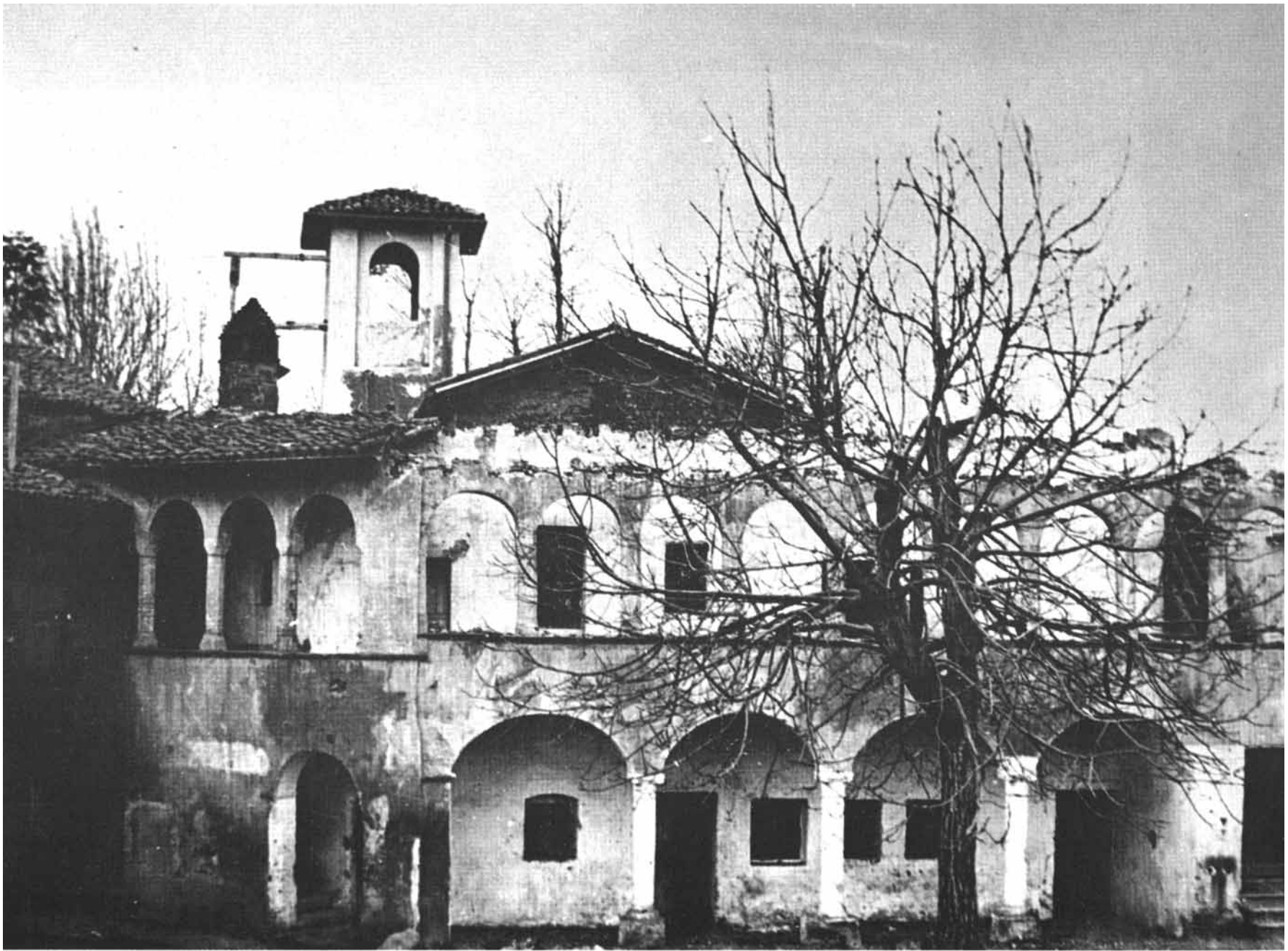
Viene demolita la casa colonica ex proprietà dei CANONICI LATERANENSIS, allo scopo di realizzare il parcheggio per autobus
