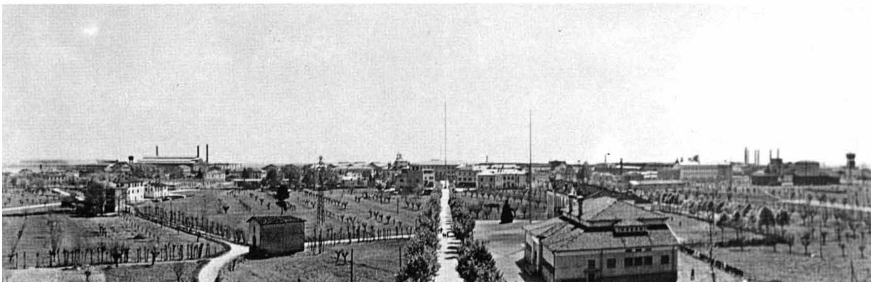
Veduta d'insieme: in primo piano il cinema aziendale DALMINE e la chiesetta del "GEROL"
