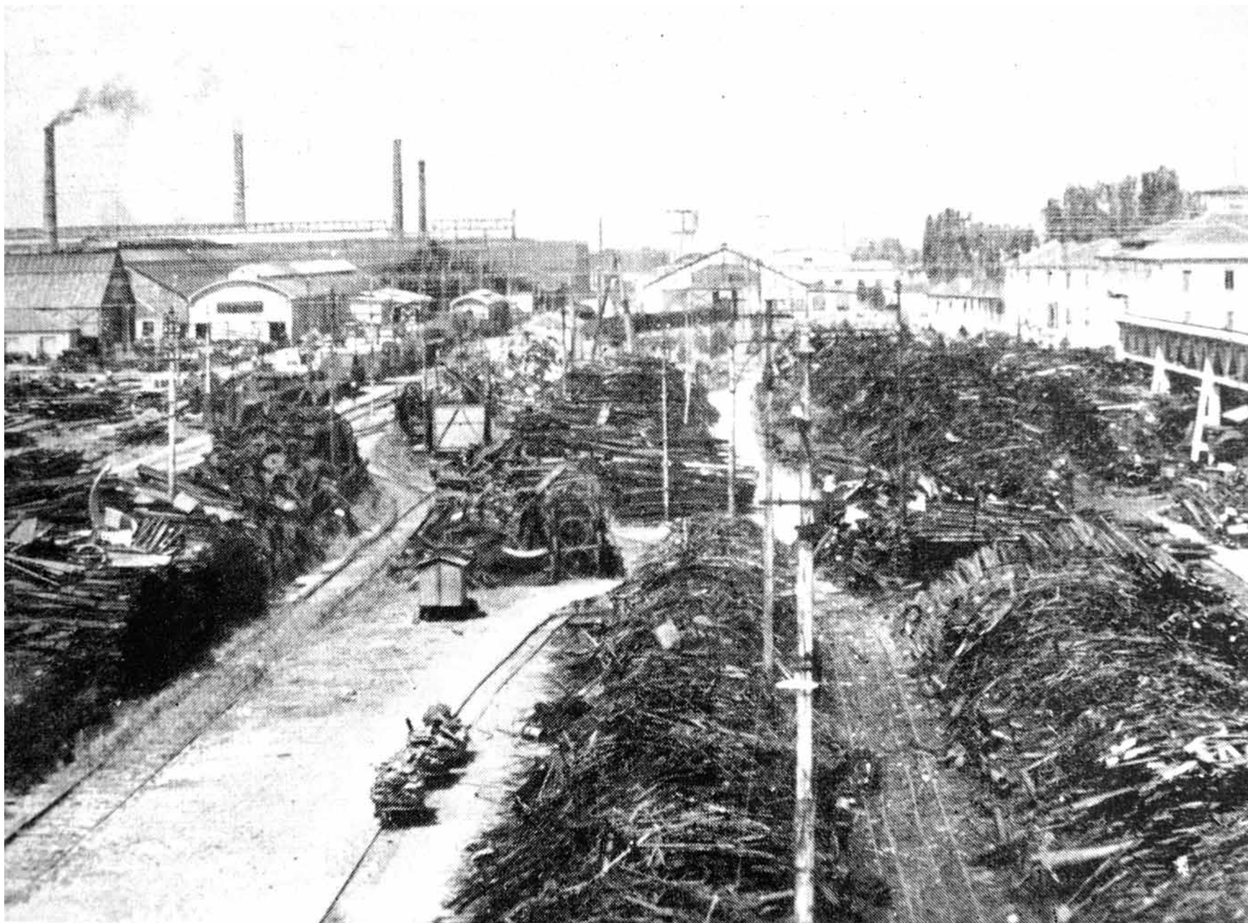
1912: il parco rottami
