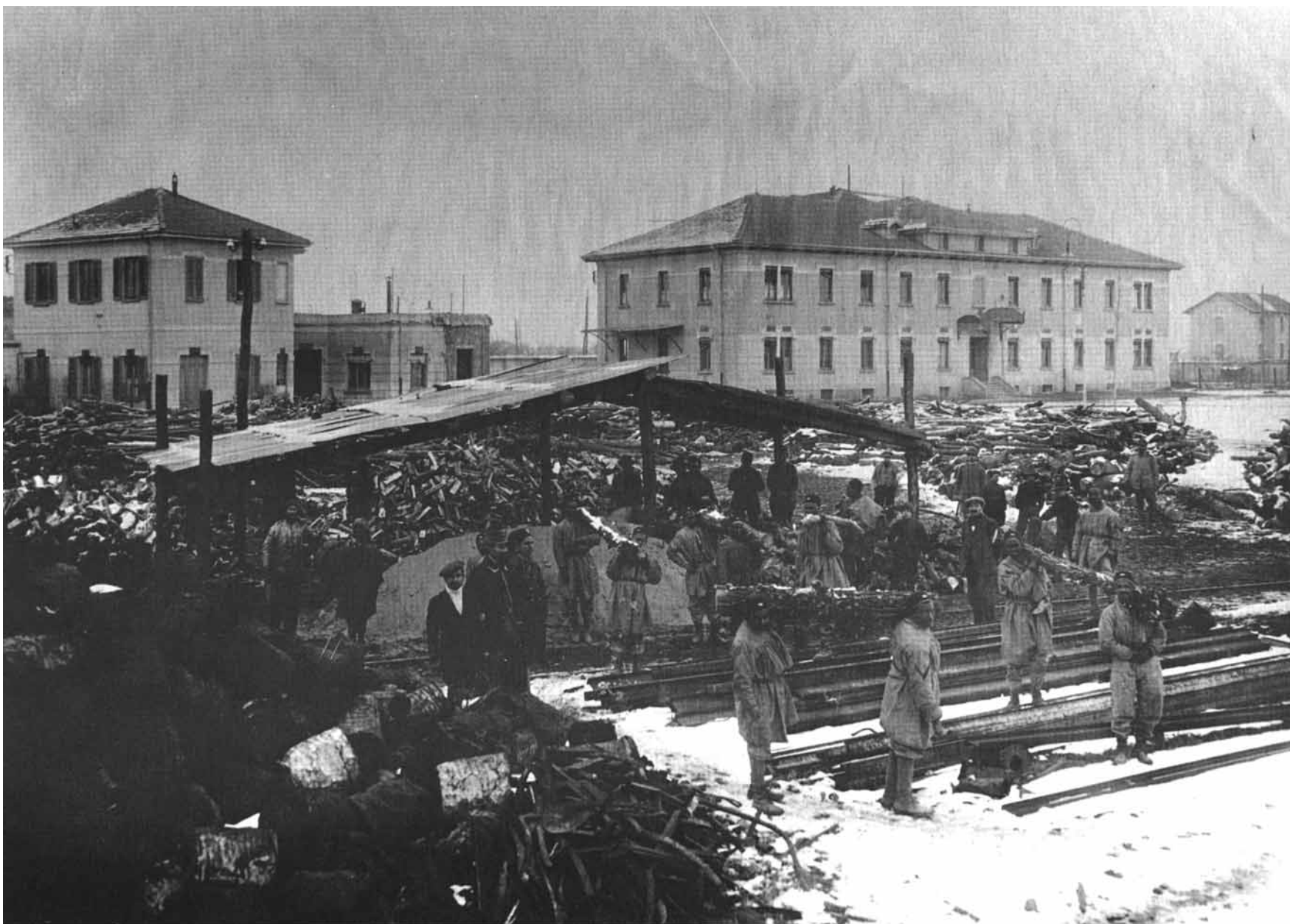
Interno dello Stabilimento durante il periodo della I Guerra Mondiale; sullo sfondo l'edificio della DIREZIONE
